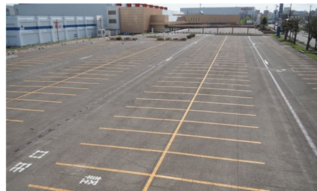
無料駐車場(第1駐車場)
